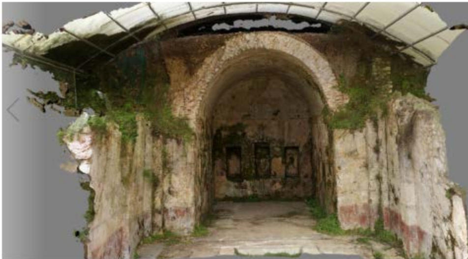
Figura 1. Il modello 3D del Ninfeo Ponari, realizzato mediante tecnica di fotogrammetria Structure From Motion.
