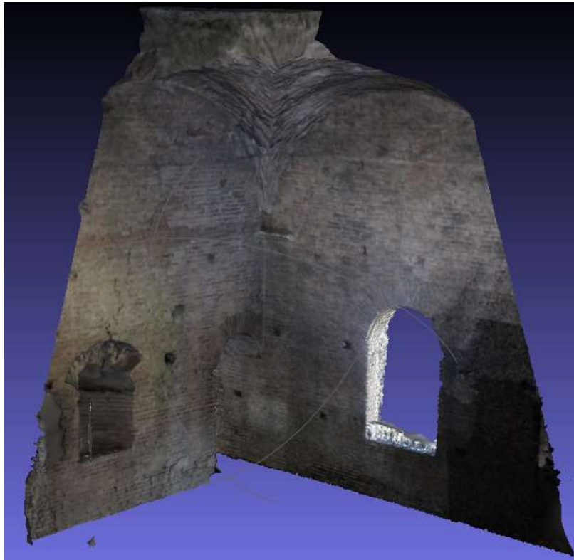
Figura 4: mura Aureliane, uno degli angoli interni della torre L3, ricostruzione 3D ottenuta con elaborazione Structure From Motion del rilievo fotogrammetrico.
