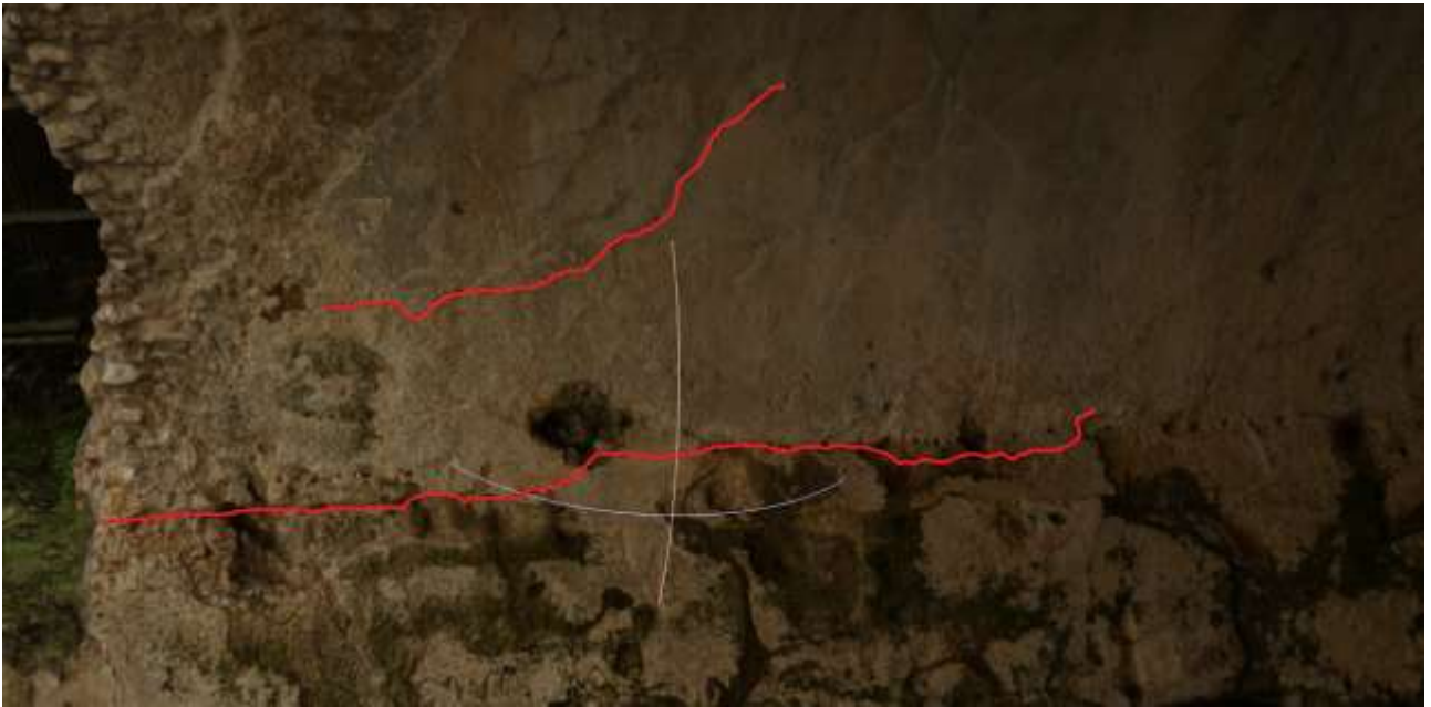
Figura 2: ninfeo Ponari, marcatura sul modello 3D di fessure presenti sulle pareti e sulla volta.
