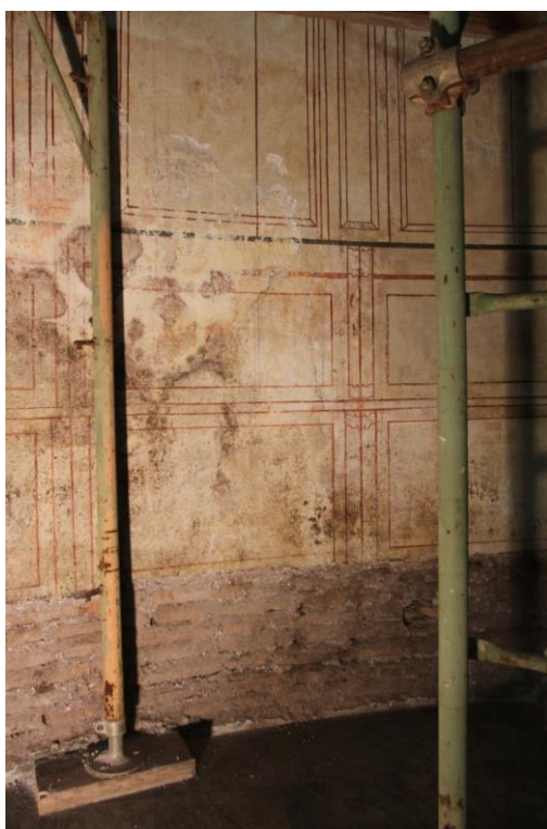
Fig. 2- Chiesa di San Nicola in Carcere, abside con ponteggi durante il restauro
