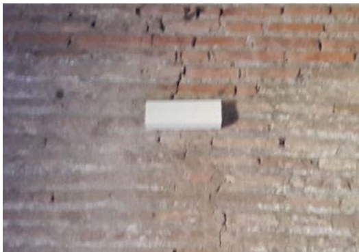
Sensore su parete Ovest (immagine sx) e sensori su parete Est (immagine dx); si notano mattoni di colore diverso, da operazione di cuci-scuci per la collocazione delle catene murate.
