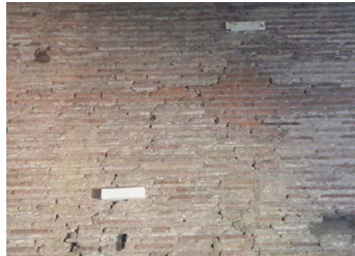
Sensore su parete Ovest (immagine sx) e sensori su parete Est (immagine dx); si notano mattoni di colore diverso, da operazione di cuci-scuci per la collocazione delle catene murate.
